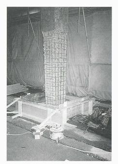
der maximale Chloridgehalt im oberen Stützenteil nicht mehr kritisch ist (unter 0,4% der Zementmasse). Der Stützenoberteil wurde vollflächig mit einer Versiegelung gegen eindringendes Wasser und als CO<sub>2</sub>-Bremse beschichtet.
