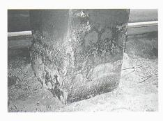
Hochdruckwasserstrahl (HDW) abgetragen und durch einen Vorbeton (Betonauftrag) ersetzt. Die gesamte Rückwand wurde nachher mit einer Hydrophobierung geschützt. Der 12 bis 15 cm starke Vorbeton wurde unbewehrt ausgeführt, die Ränder mit Dübeln gesichert. Bei der Galerie Wilerplanggen war die Betonqualität erheblich besser (der Chloridgehalt kleiner und die lokalen Mängel geringer), so dass nur ein Oberflächenschutz (Hydrophobierung) aufgebracht wurde (Bild 6 und 7).
