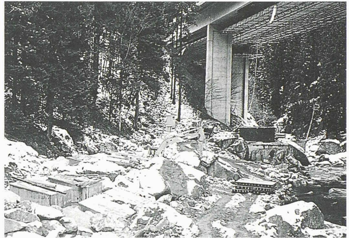
2 Betonprismen Pfeilerpaar Mitte (RO5)
