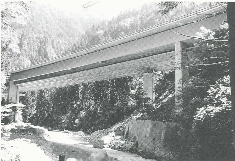
1 Überquerung der Reuss im südlichen Bereich der Brücke
