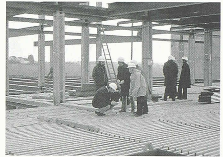
Baustellengespräche zwischen allen am Bau Beteiligten
