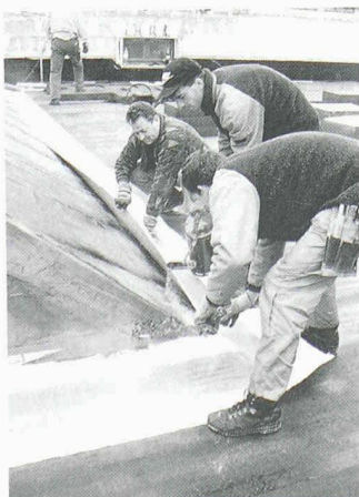
Das Dilatec-Fugendichtungsband PVC/B/500 wird unter die Dämmschicht aufgebracht
