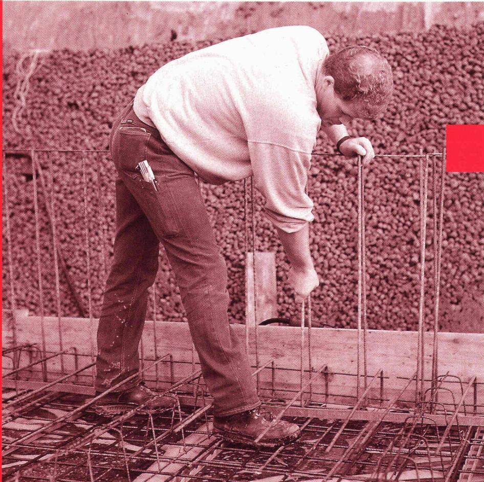
Wenn das Praktische, das Angenehme und das Wirtschaftliche so eng verschweisst sind, kann es sich nur um den FIRIPA-Anschlusskorb handeln. Im Handumdrehen massgenau und sicher - von einer Person - versetzt, erspart er das mühsame Aufstellen einzelner U-Bügel, das zeitraubende Fixieren an Längsstäben und das nervensägende Umkippen. Über die weiteren Vorteile brauchen wir uns nicht zu unterhalten. Die liegen ja buchstäblich auf der Hand. Die FIRIPA-Anschlusskörbe finden Sie im Fachhandel.
