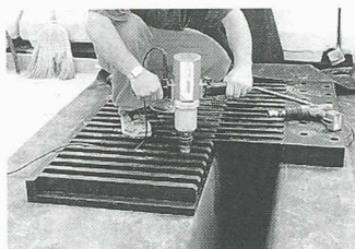
Verlegen der FlexFinger-Elemente und Einbringen des Asphaltbelages
