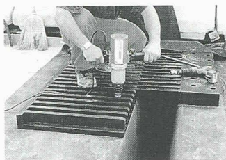
Verlegen der FlexFinger-Elemente und Einbringen des Asphaltbelages
