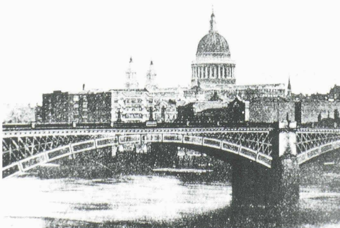
8 Brücke Southwark London, 1819 – Eisen in der Strukturform von Quaderstein
