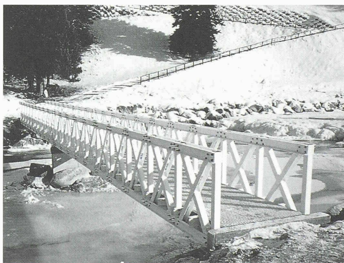
1 Brücke Pontresina, 1997 – GFK in der Strukturform von Stahl
