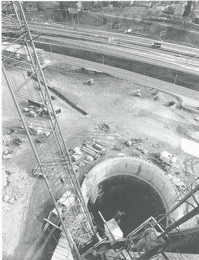
Angriffsschacht für den unterirdischen Teil der zweiten Doppelspur Zürich HB–Thalwil auf der Allmend Brunau (Bild: Comet)
