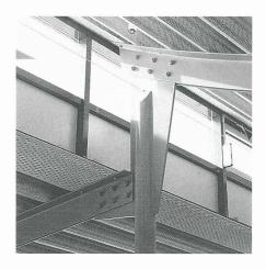
Anschlussdetail der Stahlkonstruktion (Bild: R. Lamb, Radolfzell)
