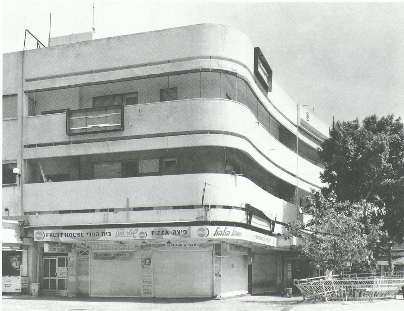
Wohnungsbau am Kikar Zina Dizengoff, 1934–1949. Architektin Genia Averbouch
