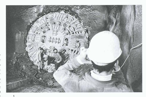
Ankunft der Tunnelbohrmaschine am oberen Ende des Druckschachts des Kraftwerks Cleuson-Dixence (Bild: Bernard Dubuis, Erde VS)
