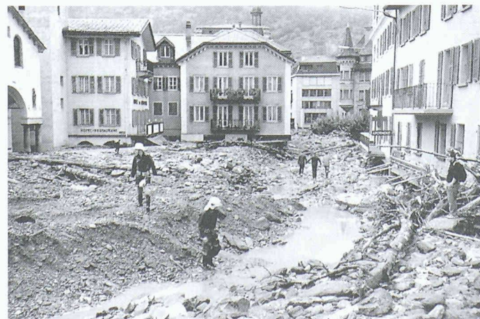
2 Das Hochwasser der Saltina in Brig-Glis vom 24. September 1993 (Bild: G. Escher)
