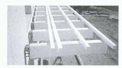
Wärmegedämmter Kragbalkon aus Holz. Sichtbar sind die Einhängezughaken und die bereits vorbereitete Queraussteifung der Balkonplatte (Bild: Schöck-Bauteile AG)
