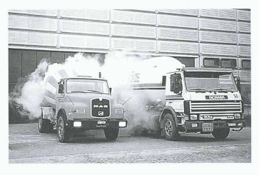
In einem Zisternenwagen wird der Flüssigstickstoff auf die Baustelle transportiert und dort direkt der Betonmischtrommel zugeführt (Bild: ETH Lausanne)
