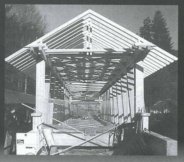
KERTO FURNIER-SCHICHTHOLZ der Werkstoff mit vielen technischen und ökologischen Stärken. Stark in den Dimensionen: Maximale Platten-Länge 23 m. Maximale Platten-Breite 1.8 m. 9 verschiedene Stärken von 27 bis 75 mm. Bewährt in vielfältigen Anwendungen. Immer stärker gefragt für kreative Lösungen im Ingenieur-Holzbau. KERTO sollten Sie unbedingt kennen lernen. Verlangen Sie unsere Referenzen.
