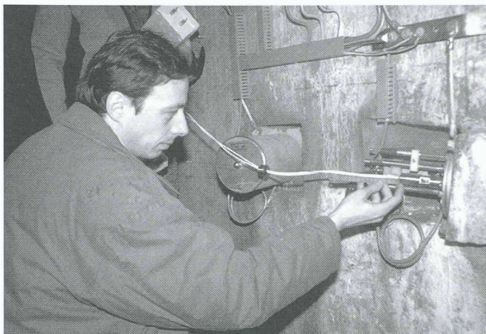
Installation eines faseroptischen, 30 m langen Extensio- meters in der Emos- son-Staumauer
