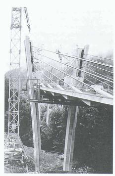
Die 540 m lange Sunnibergbrücke der Umfahrung Klosters im Bau: Gut sichtbar die auseinanderstrebenden Pylonpfeiler und die dünne Fahrbahnplatte (Bild: Comet)
