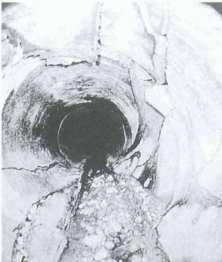
Stark zerrissenes Rohr, das einzustürzen droht
