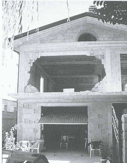
Herausgefallene Mauerwerksausfachung eines Einfamilienhausneubaus
