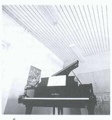
Aufbau der Schallabsorption zur Reduktion der Halligkeit. a) Schema mit 1: Decke, 2: Hohlraum mit Absorption, 3: Absorptionsmaterial, 4: Faservlies, 5: Massivholzriemen und b) Foto (S. Schenker, Therwil)
