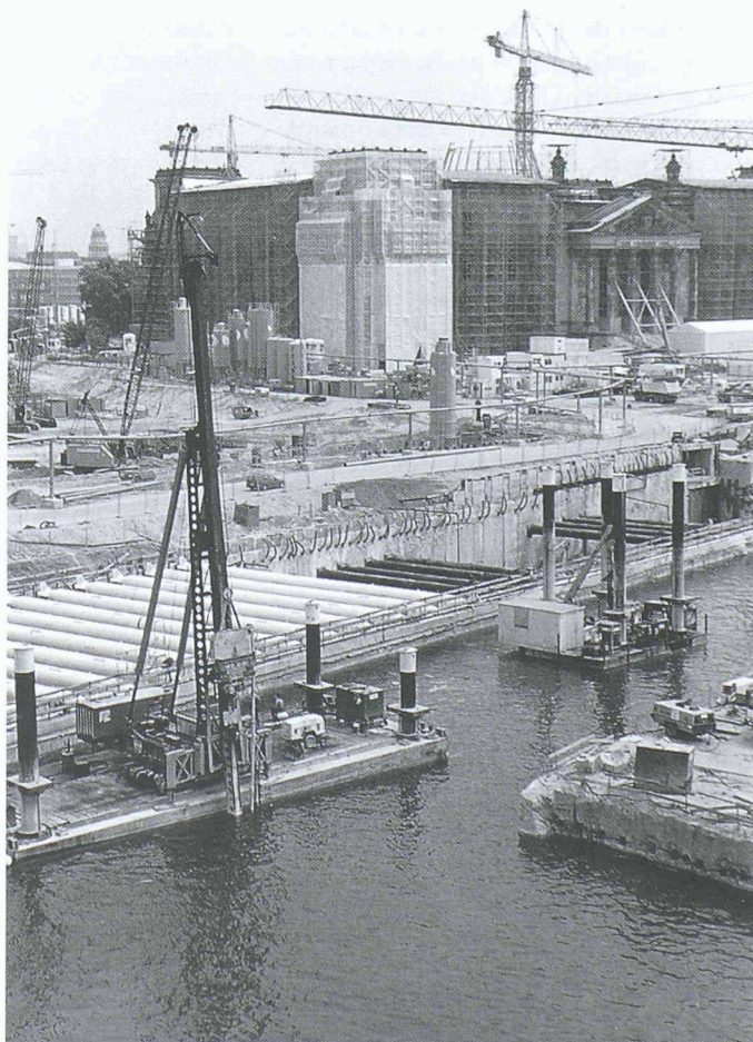
Blick vom Dach der Schweizer Botschaft. Im Vordergrund die Baugruben für die Tunnels (rechts geflutet, links trockengelegt), im Hintergrund das Reichstagsgebäude. Auf dessen Dach entsteht Norman Fosters Glaskuppel (Bilder: Daniel Kohler)
