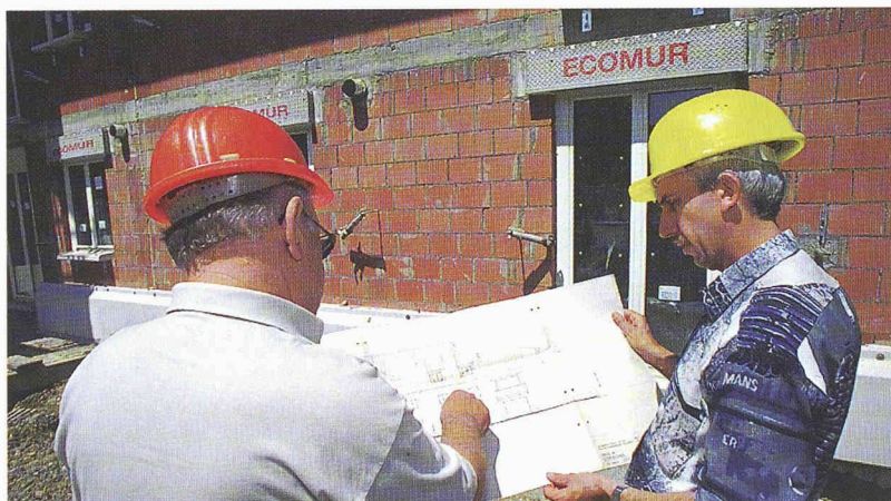
... bei der Ausführung ...
