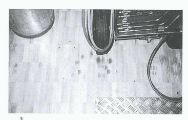
Wässriger Siegel war nicht inert: Bestandteile reagierten mit dem Gummireifen und führten zu durchgehenden Verfärbungen der Lackschicht
