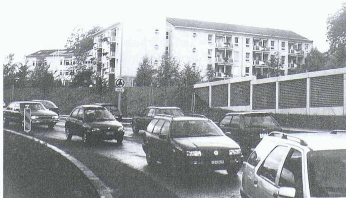
1 Traditioneller Lärmschutz: Lärmschutzwände und Lärmschutzdämme
