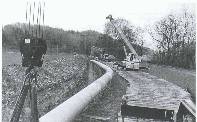
2 In sensiblen Gebieten verkehren die Baumaschinen nur auf Baggermatratzen
