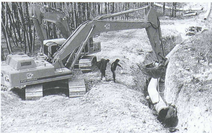
1 In Wäldern wird der sonst schon relativ schmale Baustreifen auf ein Minimum eingeengt
