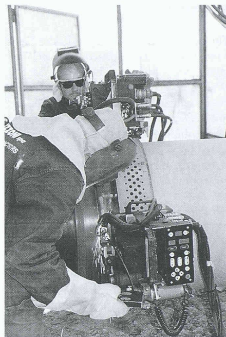
Der grösste Teil der rund 4000 Nähte wird – als Novum im Schweizer Leitungsbau – mit Automaten im Schutzgasverfahren geschweisst und mit computerüberwachtem Ultraschall geprüft
