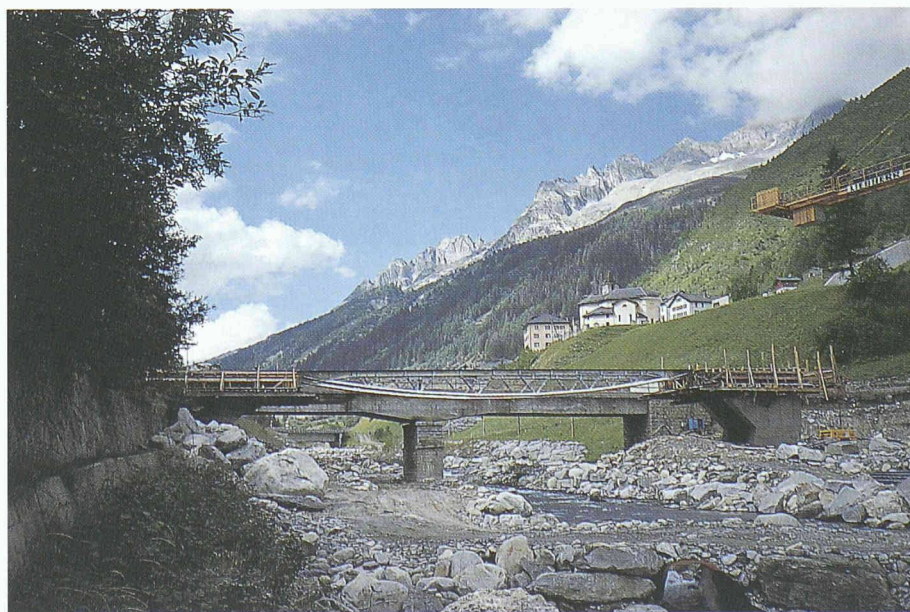
10 Brücke über den Tessin bei Villa Bedretto, Bauzustand
