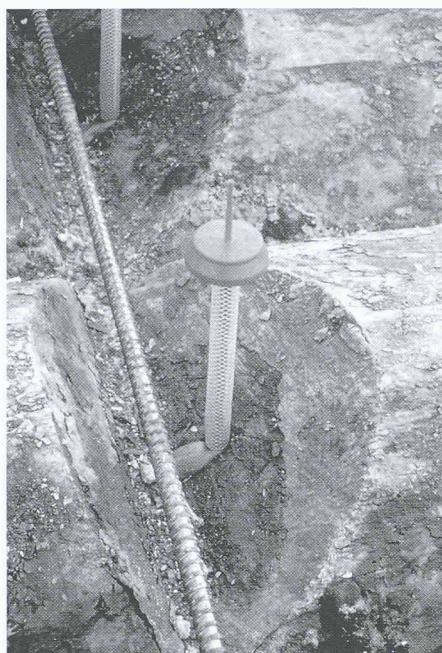
Detail der Kerbe und vorgespannter Dübel
