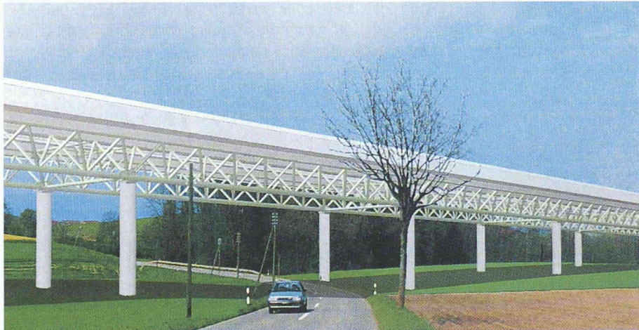
8 Viadukt von Lully (CH) – Rohrfachwerk
