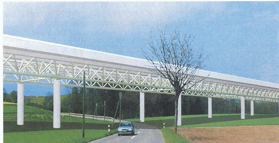
8 Viadukt von Lully (CH) – Rohrfachwerk
