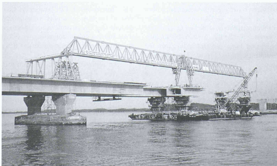
6 Second Crossing: Obenliegendes Versetzgerüst
