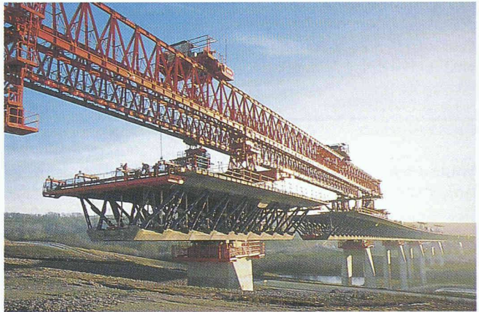
8 Boulonnais-Viadukt: Segment mit Raum- fachwerk
