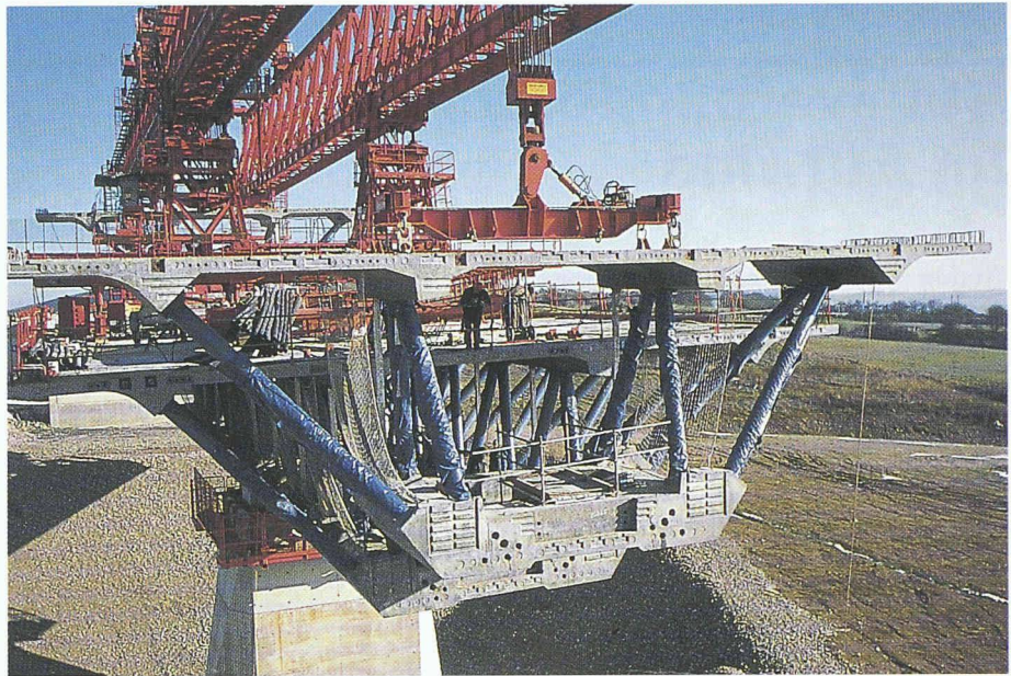
8 Boulonnais-Viadukt: Segment mit Raum- fachwerk
