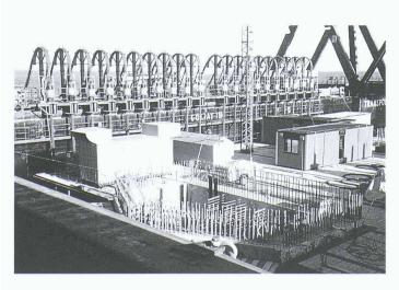
Absenkvorgang in die endgültige Position. Auf jedem der beiden Pontons sind 20 VSL-Litzen-Hebe-Absenkgeräte vom Typ SMU-330 in einer Reihe angeordnet
