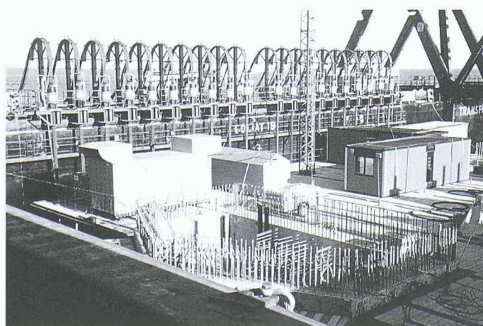
Absenkorgang in die endgültige Position. Auf jedem der beiden Pontons sind 20 VSL-Litzen-Hebe-Absenkgeräte vom Typ SMU-330 in einer Reihe angeordnet
