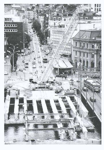
Abbrucharbeiten der alten Brücke. Der Raupenkran hebt die Längsträger heraus
