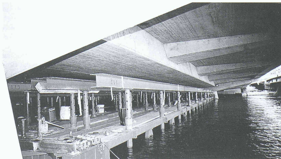
Untersicht mit dem teilweise im Wasser liegenden Lehrgerüst
