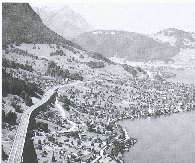
Bei der Fugensanierung am A2-Lehnenviadukt in Beckenried kam eine neue Lösung zur Anwendung
