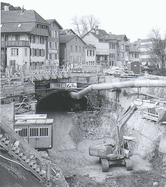
3 Blick auf das Tunnelportal Ost des neuen Tunnels mit dem Kalottenvortrieb unter den Gebäuden
