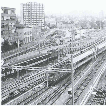
6 Inselbaustelle (Gleisbau) zwischen provisorischen Streckengleisen
