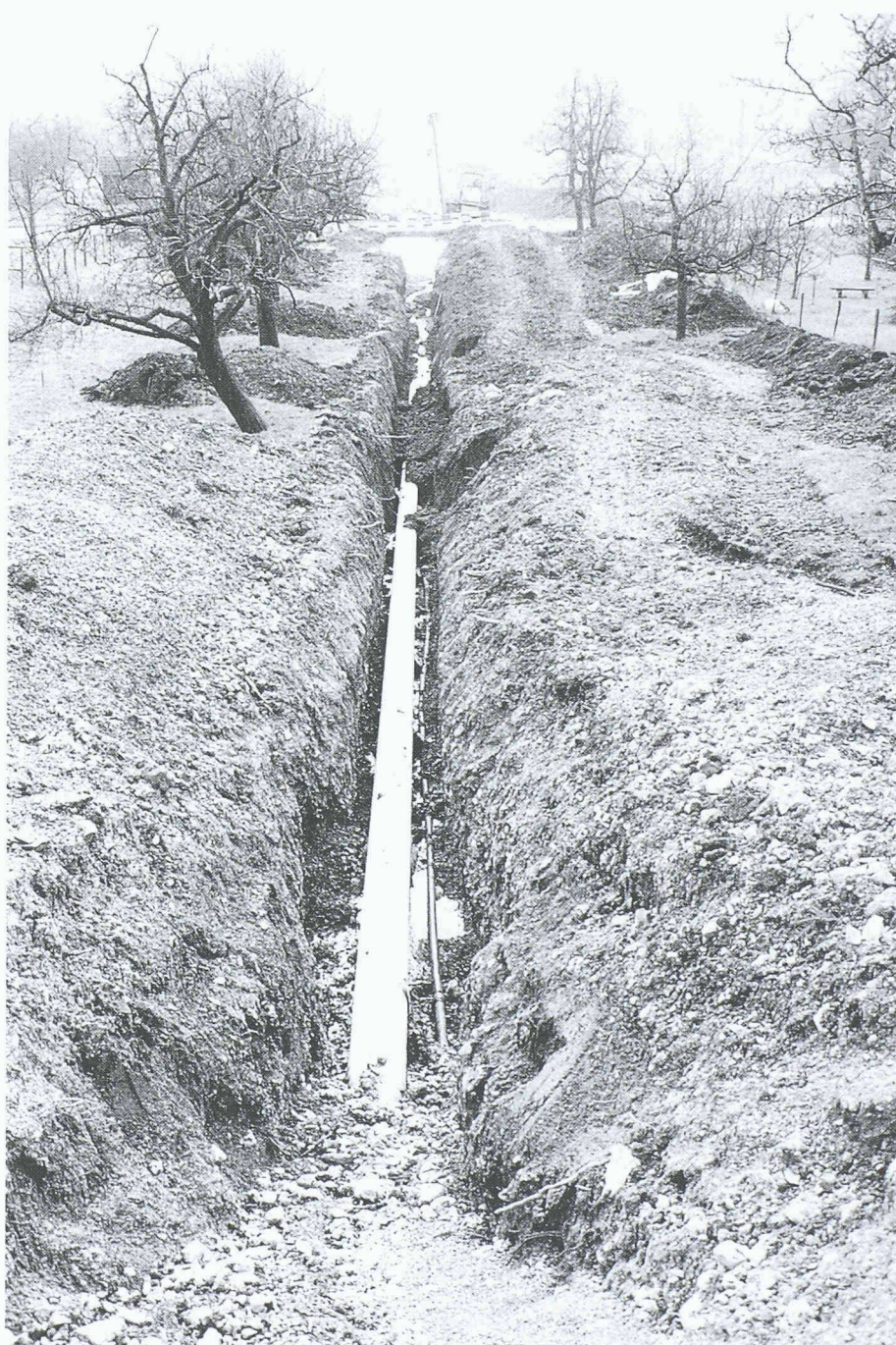
Typische Linienbaustelle: Verlegung von Rohrleitungen. Für die ökologische Baubegleitung liegen hier die Schwerpunkte auf dem Boden-
