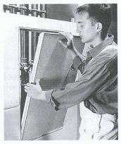
Brandbeständig und wirtschaftlich: Als F-90-Verkleidung für vertikal verlegte Kabeltrassen zugelassen ist die abgebildete Knauf-Vorsatzschale W628. Geprüft sind zwei Unterkonstruktionen und passende Revisionsklappen
