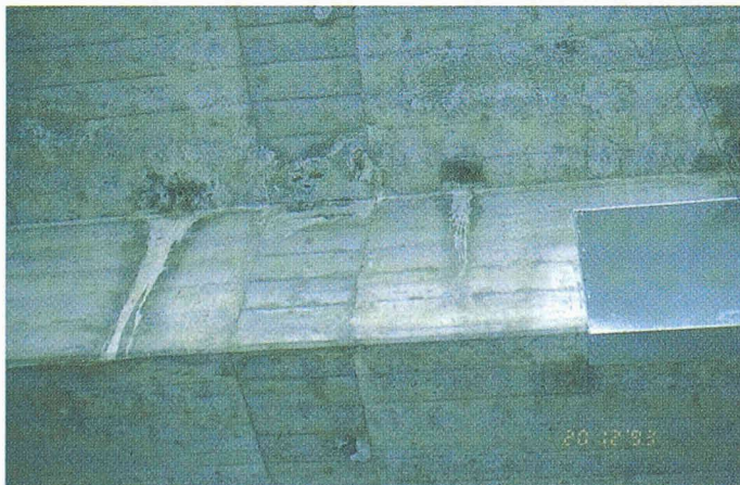
Korrodierte Spannkabel oberhalb der Hohlstrasse
