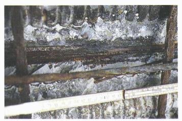
wasserstrahlen an Stellen mit unvollständiger Injektion (Luftblasen) perforiert oder aufgerissen wurden. In der Regel wurden beim Freilegen stark korrodierter und bereits perforierter Hüllrohre grössere Stücke des geschädigten Hüllrohrs weggerissen und anschliessend der Injektionsmörtel lokal abgesprengt. Dadurch wurden die äusseren Spanndrähte bereichsweise einsehbar.
