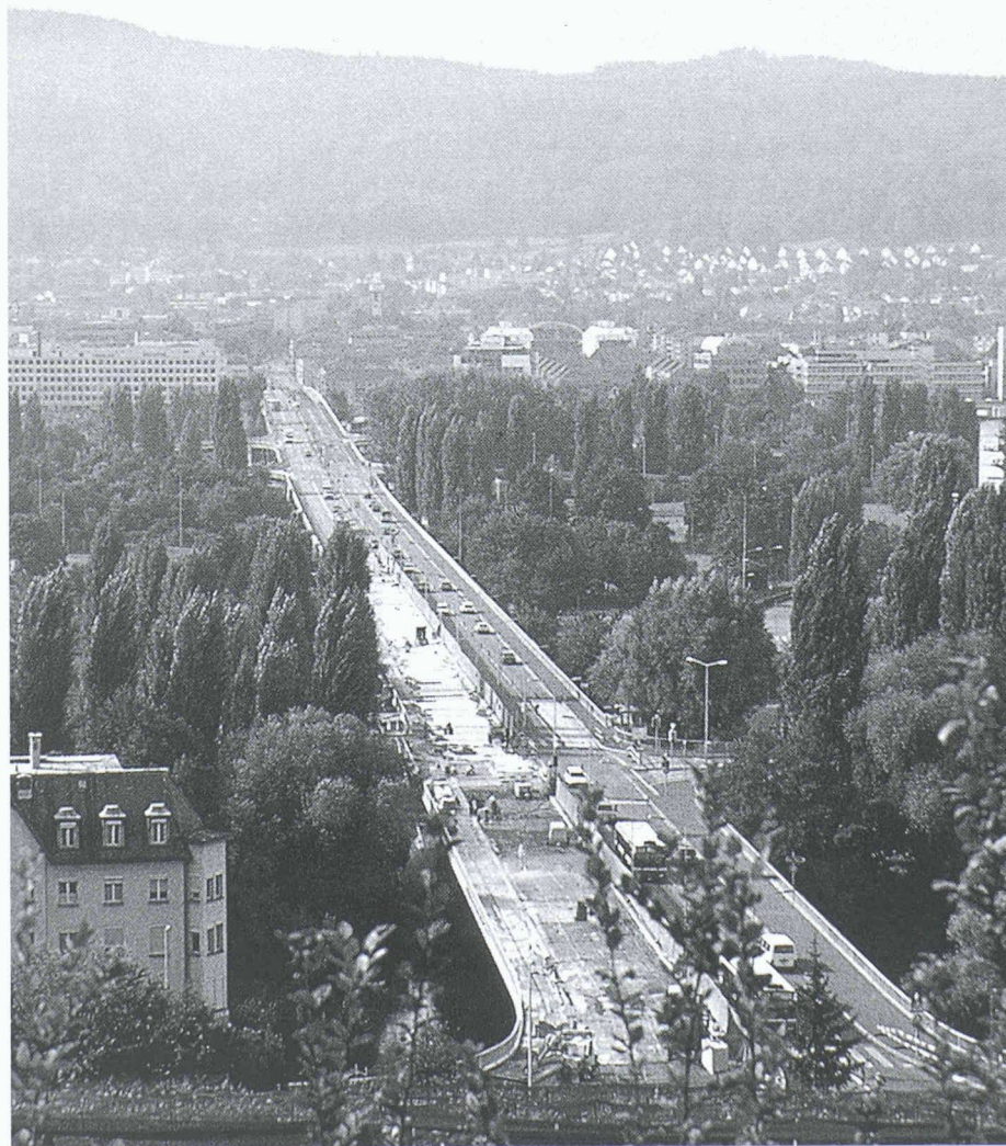
1 Instandsetzung der Brückenoberfläche in Etappen
