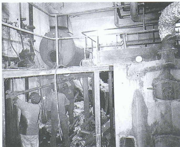
Demontage einer veralteten Heizungsanlage in Tschechien
