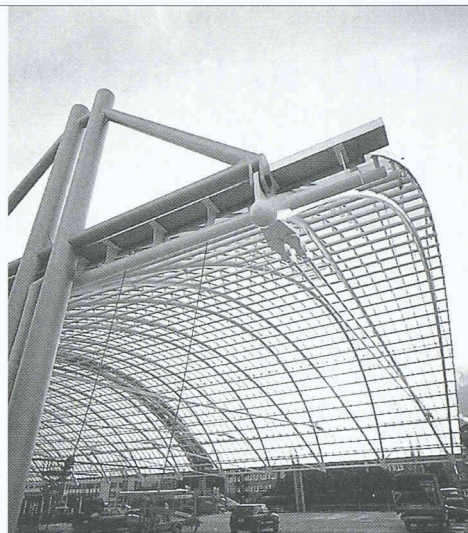
Projekt: Postautostation Chur Hallendach Architekten: Brosi, Chur & Obrist, St. Moritz
