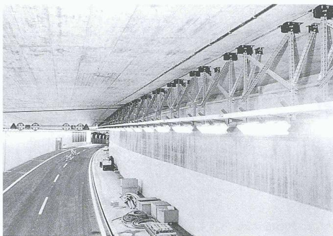
Polyester-Kabelbahn und Multifix-Trägersystem im Tunnelbau
