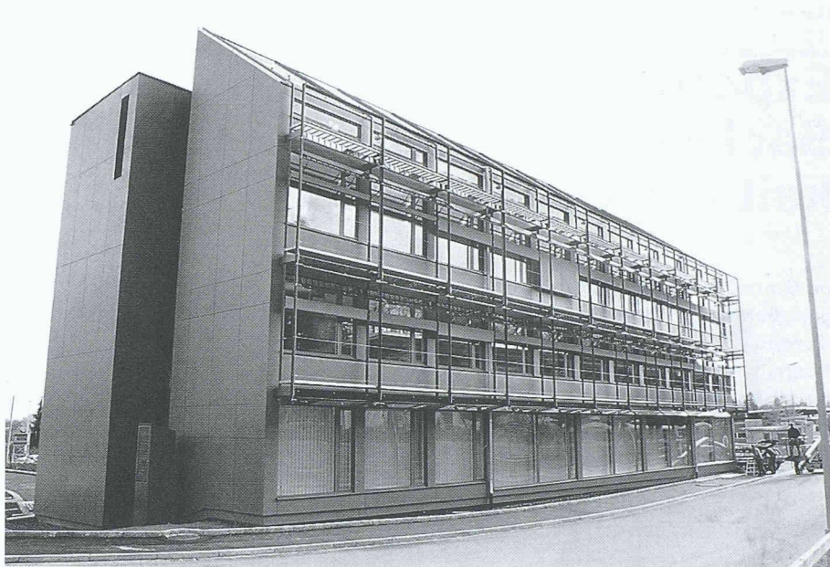
4 Ausgeführte Fassade mit Sonnenschutzsystem
