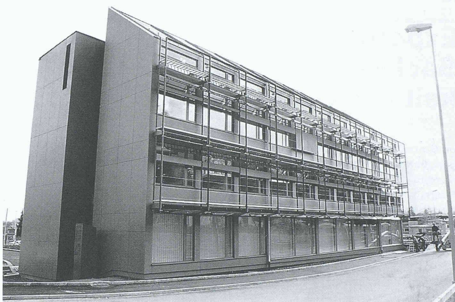
4 Ausgeführte Fassade mit Sonnenschutzsystem
