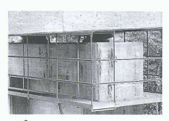
Pfeiler Nord, Spur Lora, Ansicht Stützenkopf Steg Nordseite mit Betonabplatzungen und freiliegender Bewehrung
