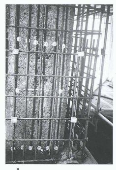
Auf der aufgerauhten Betonoberfläche wurde das Anodennetz aus Titan fixiert. Davor befindet sich die neue Bewehrung für die Betonummantelung
