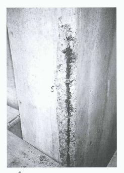
Betonabplatzung und rostige Bewehrung (Längseisen und Bügel: Querschnittsverminderung rund 10% infolge chloridinduzierter Korrosion)
