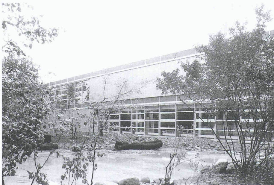
Baukastensystem Midi Armilla, Kantonsschule Solothurn: Die Wandelbarkeit, Aus- und Rückbaubarkeit des Baukastensystems Midi Armilla konnte bereits an verschiedenen Objekten gezeigt werden, etwa der HTL Brugg-Windisch oder dem SBB-Ausbildungszentrum Löwenberg in Murten. Das System vereint die Anforderungen der Nachhaltigkeit mit ökonomischer Flexibilität
