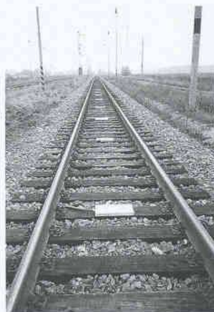
7 Versuche mit Eurobalisen (erkennbar als Platten zwischen den Schienen), oben und Eurobalisen-Antennen verschiedener Hersteller am Messwagen, unten
