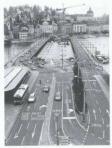
Der Brückenneubau entsteht zwischen den beiden Hilfsbrücken, die den Verkehr während der Bauzeit aufnehmen. In diesem «Loch» erkennt man die Bohrpfähle für die Fundation (Bild: Comet)
