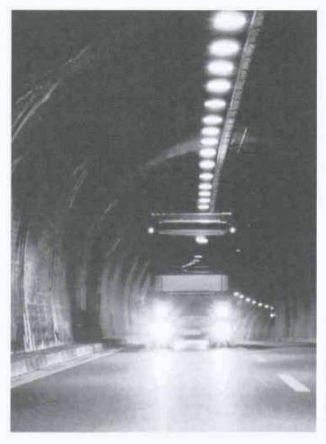
Tunnel du Flonzaley an der Autoroute du Léman: Dank der äusserst langen Lebensdauer der OL-Lampen von mehr als acht Jahren im Dauerbetrieb entstehen keine Störungen im Verkehrsfluss  Es sind keine Zuführungsdrähte wie bei Glühlampen oder Gasentladungslampen erforderlich, die an den Glas/Metall-Durchführungen thermisch belastet werden.
