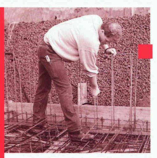
Wenn das Praktische, das Angenehme und das Wirtschaftliche so eing verschweisst sind, kann es sich nur um den FIRIPA-Anschlusskorb handeln. Im Handumdrehen massgenau und sicher - von einer Person - versetzt, erspart en das mühsame Aufstellen einzelner U-Bügel, das zeitrauberide Fixieren an Längsstäben und das nervensägende Umkinpen. Über die weiteren Vorteile brauchen wir uns nicht zu unterhalten. Die liegen ja buchstäblich auf der Hand. Die FIRIPA-Anschlusskorbe finden Sie im Fachhandel.
