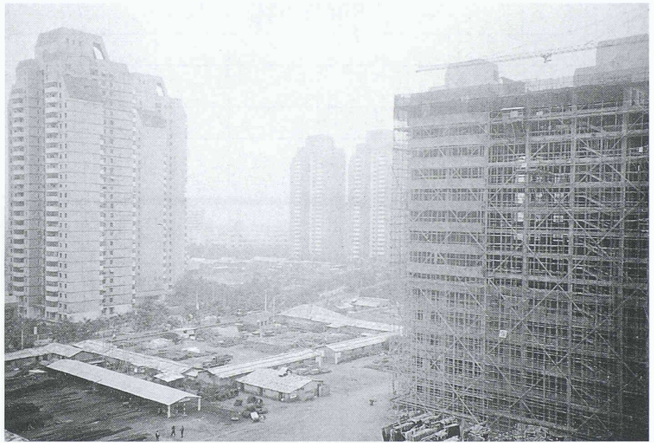
Grossbaustelle in Peking, in der Mitte provisorische Nebengebäude mit Materiallager (Metall, Holz)
