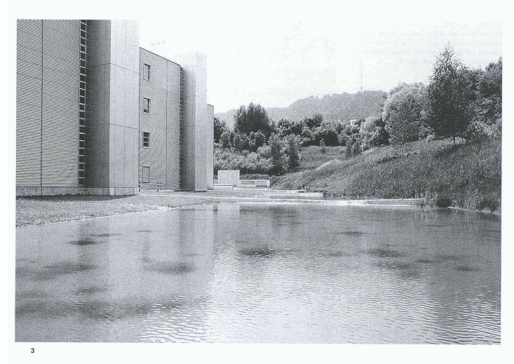
wird in sechs linsenförmige Becken von 480 m³ Inhalt eingeleitet (4). Die 168 Us werden dem Vorfluter mit 5 I/s, also stark verzögert, abgegeben. Bei trockener Witterung sind diese Becken leer und liegen erdskulpturartig vor dem Betriebsgebäude.
