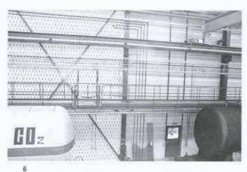
Absorbierende Wandverkleidung, Links: Soundblox-Akustiksteine, rechts: perforiertes Profilblech (Objekt: Neubau Servicehalle Meyer Waggon AG, Rheinfelden)
